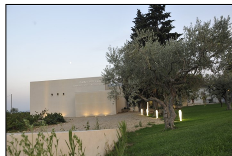
Winery at Saint Préfert
