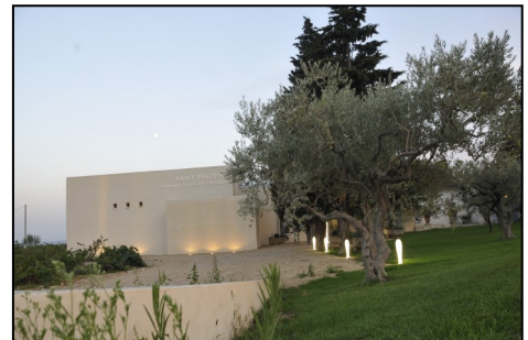
Winery at Saint Préfert
